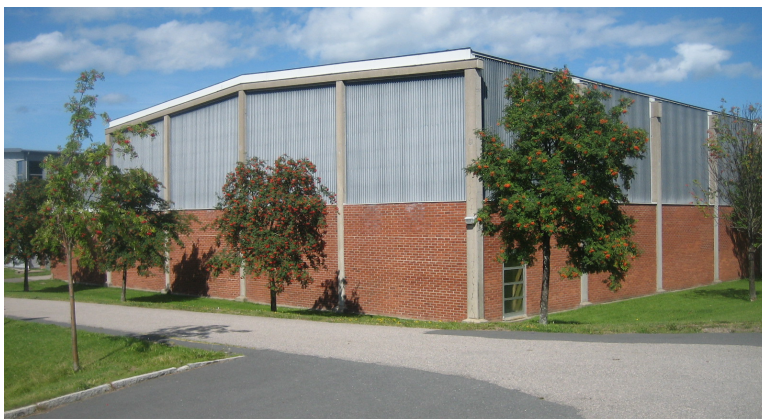
Idrottshallen foto från söder
