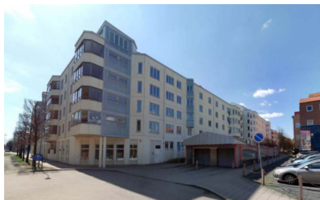
Bostadsbebyggelse inom Hälsan 1 samt garagenedfart sett från Barnarpsgratan.
