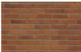
Fasad i rött tegel på befintlig nätstation.
