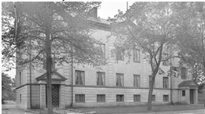
Gamla tekniska yrkesskolan Kv Globen
