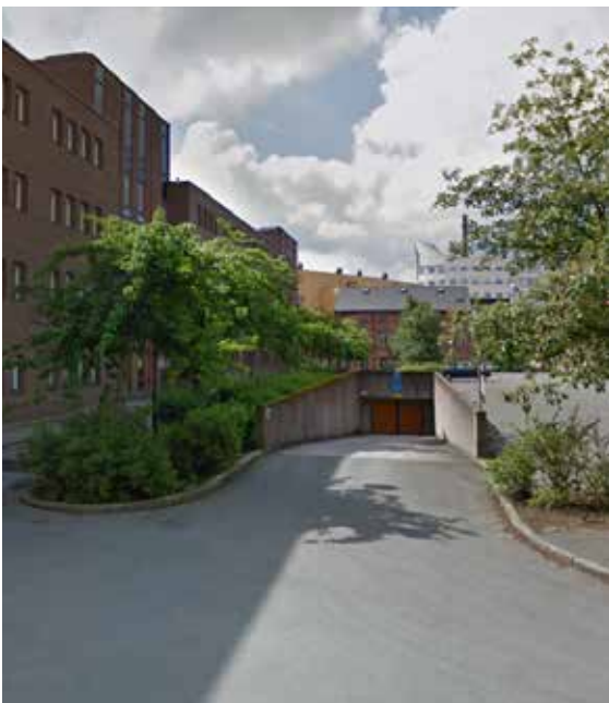
Foto taget mot söder. Dagens nedfart som ligger mitt i Verkstadsgatan tas bort och förläggs istället i den nya byggnaden på Kv. Grävlingen.
