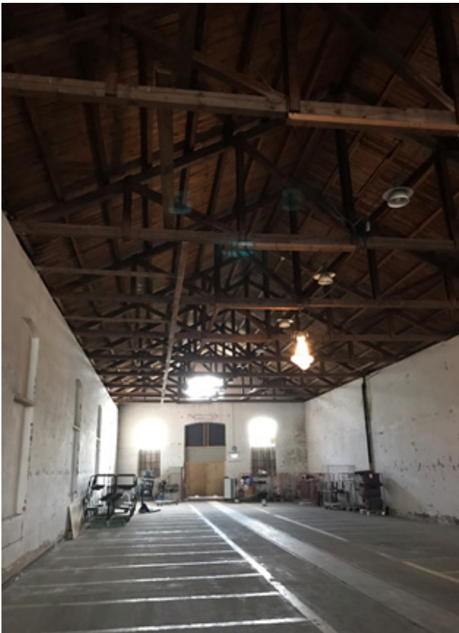
Interiör från en av de parallella hallarna i Säckfabriken. Varje enskilt byggnadsskepp utgör en enda stor rumsvolym. Takkonstruktionen består av fackverkstakstolar i trä.
