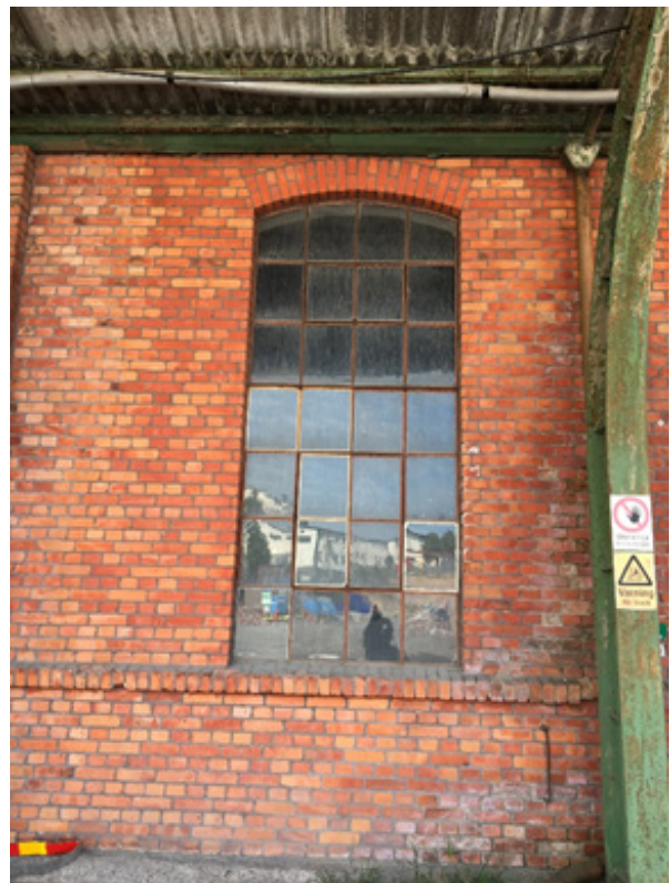
Detalj av öppningsbart fönster på Säckfabrikens västra fasad.
