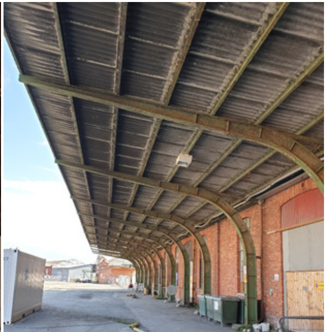
Detalj av skärmtaket utmed Säckfabrikens västra fasad. Skärmtaket löper utmed byggnadens fulla längd. Skärmtaket bärs upp av böjda stål balkar med fäste i mark och stag i fasad.
