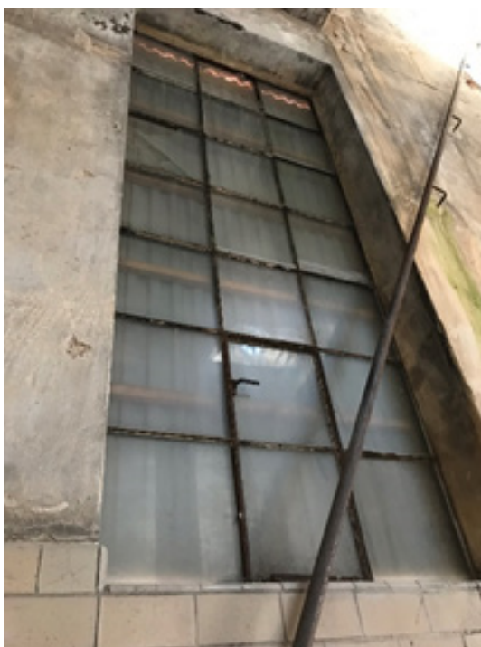
Detalj av Panncentralen och bottenvåningens höga och smala fönster med gjutjärnsbågar 3x7rutor vardera (Nu täckta med plåt).
