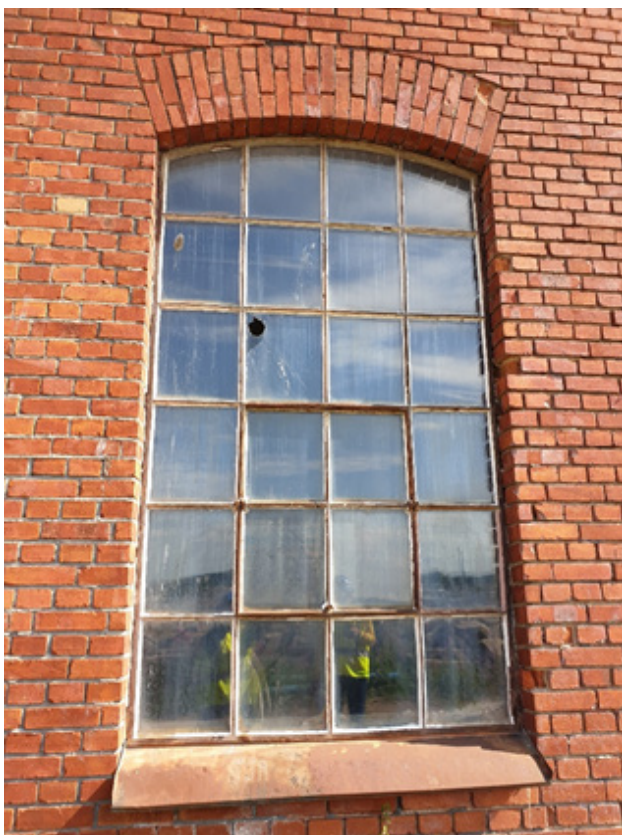
Detalj av öppningsbart fönster på Säckfabrikens södra fasad
