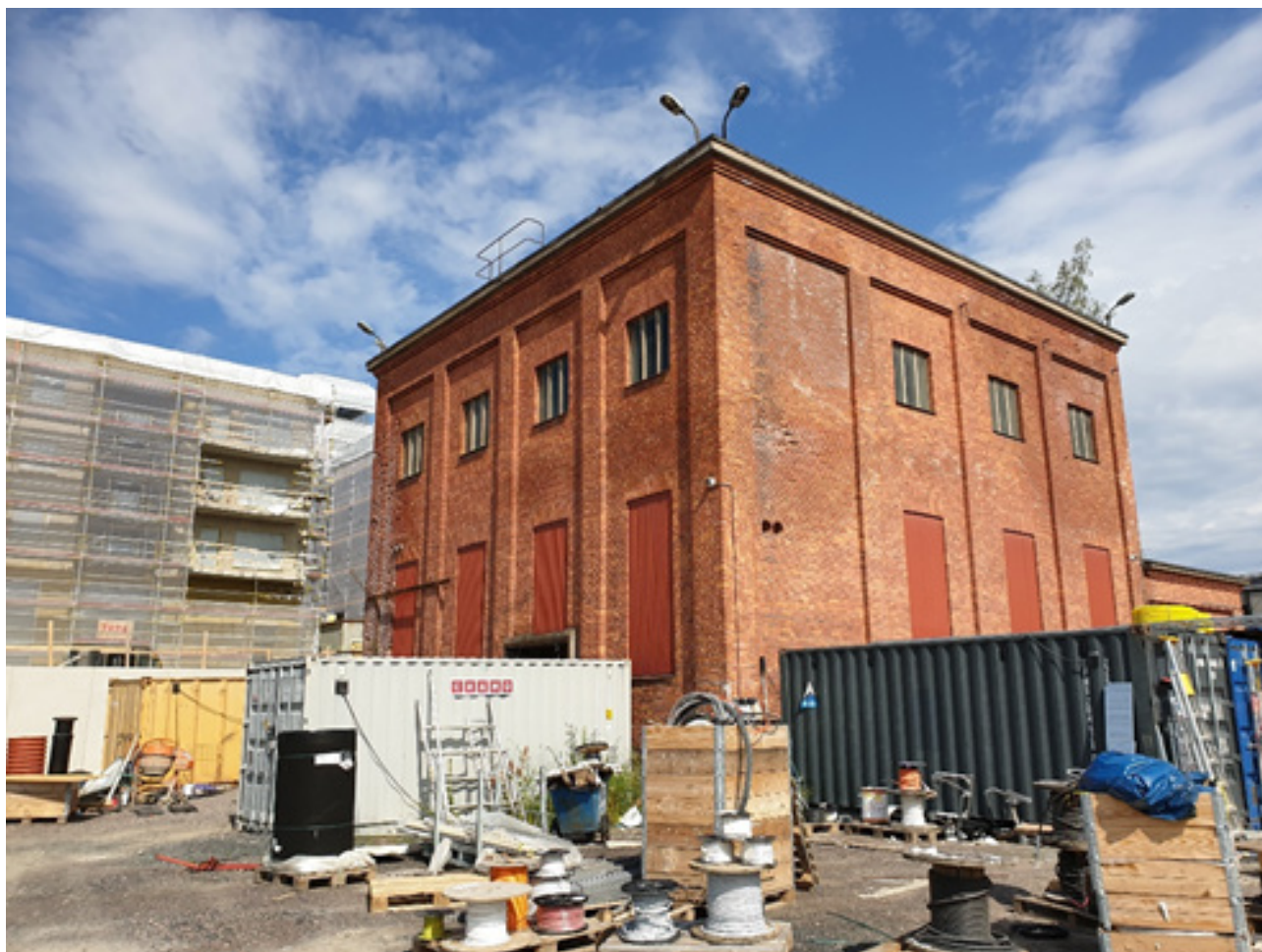
Exteriört från Panncentralens södra och östra fasad.
