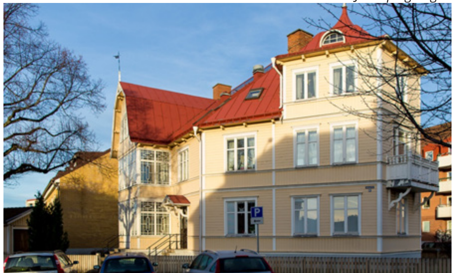
Gårdsfasad mot Jönköpingsvägen
