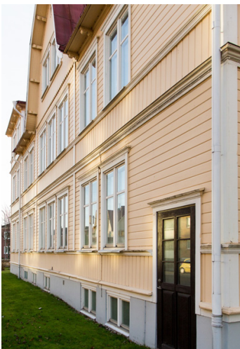
Fasad mot Vättergatan
