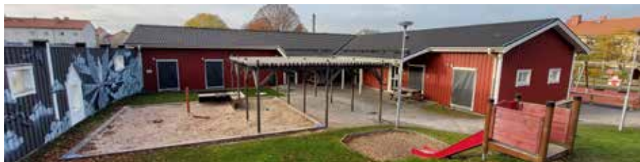
Bild 14. Förskolebyggnadens östfasad med Hermansvägen bakom motivmålat bullerplanketplank till vänster i bilden
