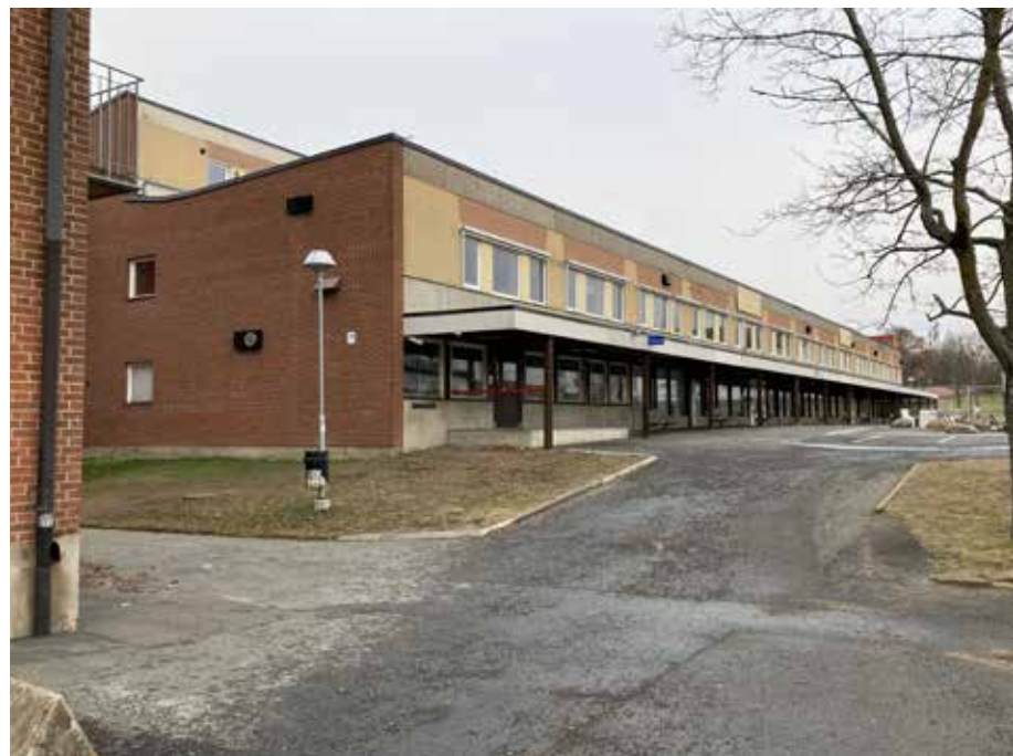
Bild 8. Högstadiets södra sidan, här föreslås prickmark. Skärmtak ger skydd på ett fint sätt. Fönstersättningen på denna sida gör att ljuset kommer långt in i byggnaden och reflekteras upp från skärmtakets ovansida. Byggnaden är utformad med omsorg om detaljer.
