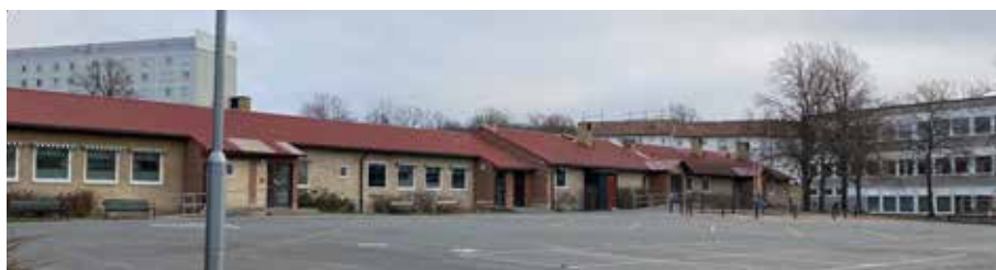
Bild 13. I byggnaden finns lokaler för trä- och metallslöjd samt hemkunskap. (Från början var det en matsal där.)
