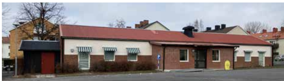
Bild 12. visar en byggnad i norra delen av skolområdet som kommer att rivas. Idag är där syslöjd.
