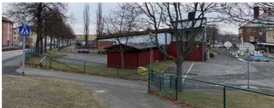
Bild 15. Skolans matsal kan komma att ersättas sent i omvandling av skolans olika byggnader.
