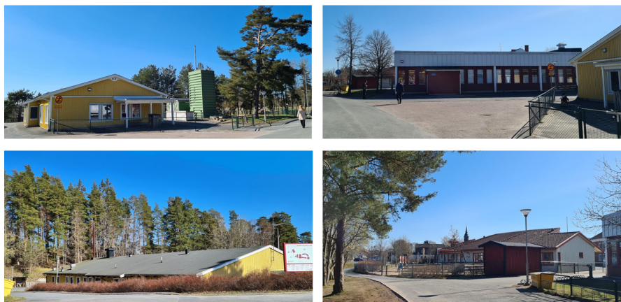
Befintlig bebyggelse i skolområdet
